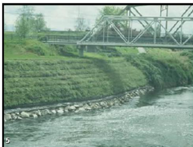
Figura 3.5 – Soluções de bioengenharia para recuperação de canais fluviais (1) Estacas; (2) Feixes / caniçadas / banquetas vivas; (3) enrocamento vivo; (4) esteira viva; (5) Geogrelha vegetada, adaptado de Schmeier (2012).
