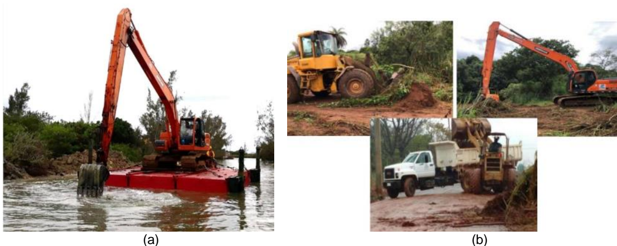
Figura 3.3 – (a) Escavadeira de braço longo em balsa com sistema de ancoragem; (b) movimentação do material para bota fora (Fonte: Arquivo Vale, 2019).
